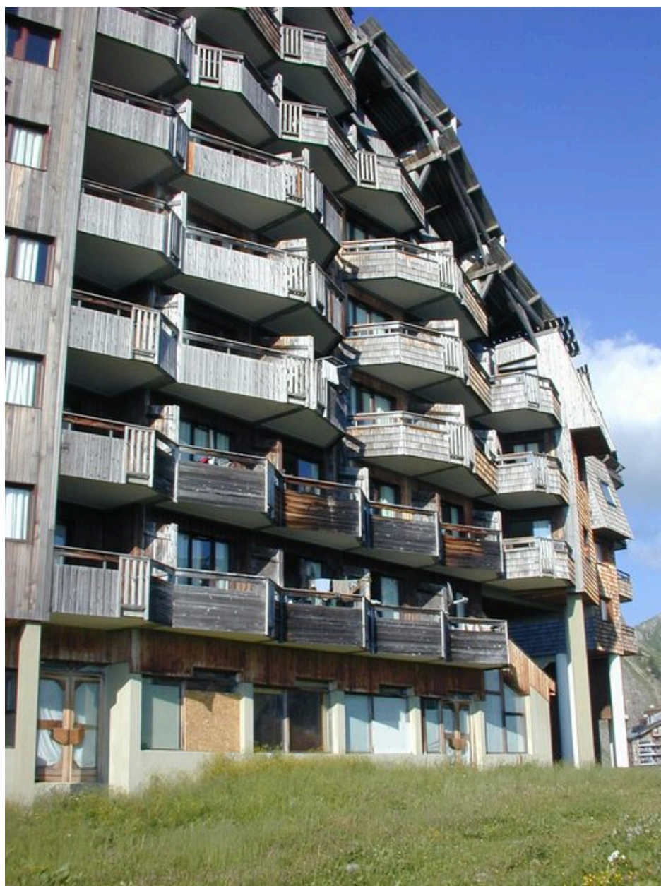
Façade sud depuis l'ouest
