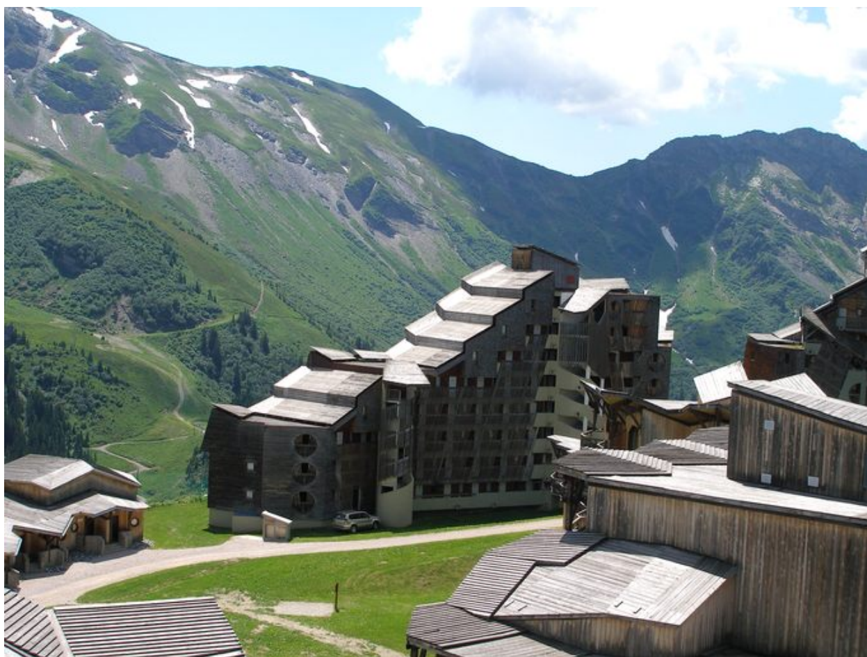
Vue d'ensemble depuis le nord : les toitures
