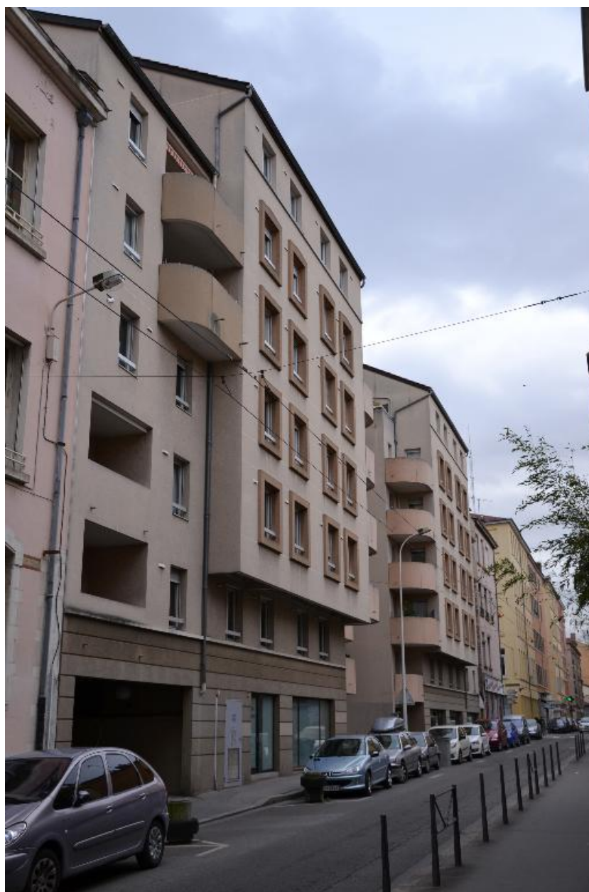
Vue d'ensemble façade ouest
