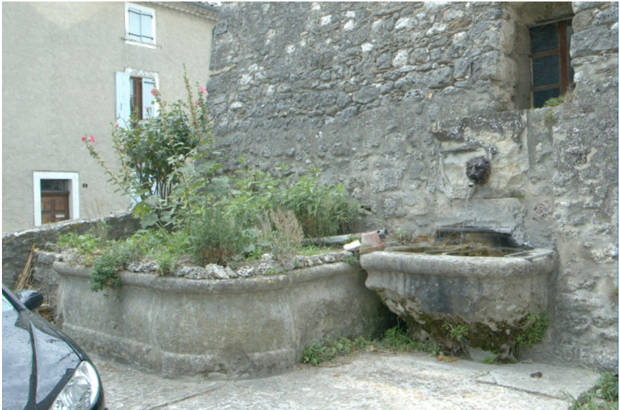
Salles-sous-Bois. Place du Cabaret, fontaine et ancien lavoir vus de trois quarts.
