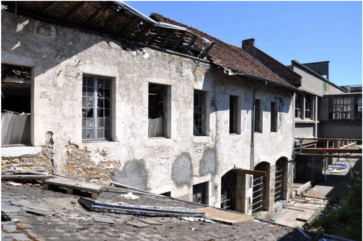
Façade latérale nord du bâtiment ex-machine 2.
