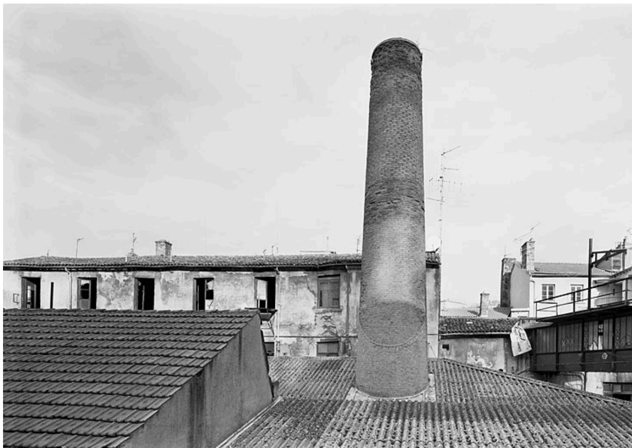
Cheminée en brique
