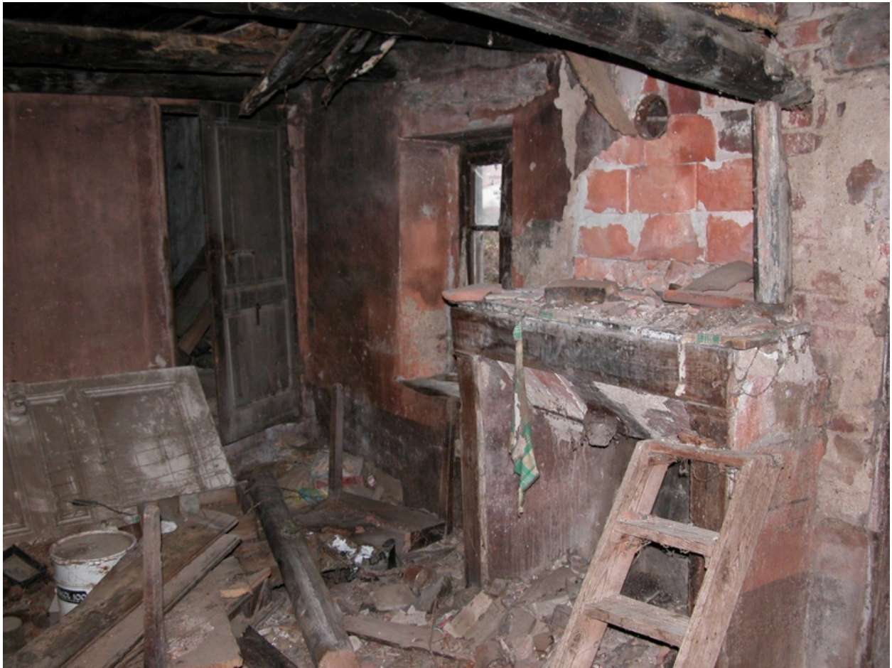
Vue intérieure de la chambre attenante au logis.
