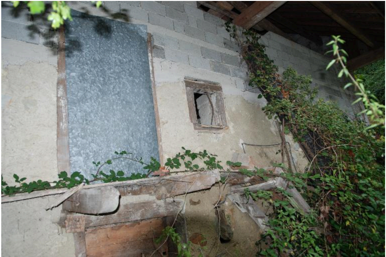
Sous la Carrière, ferme, 2017 C1 1127. Détail de la porte d'accès aux chambres.
