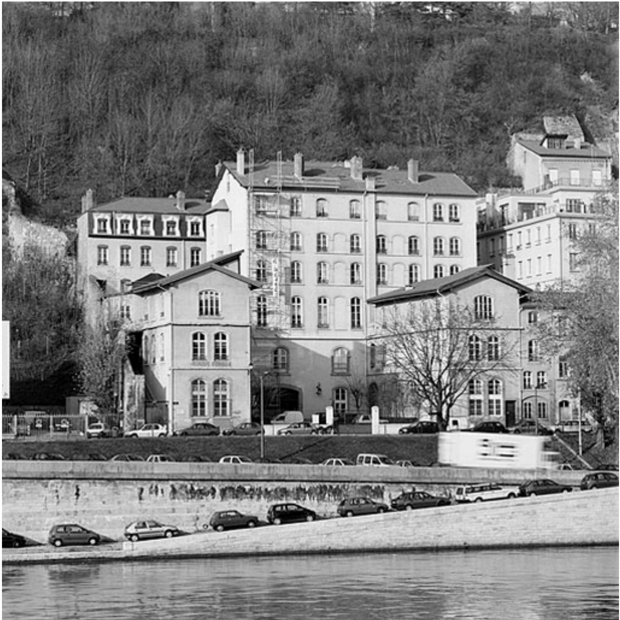
Vue est des bâtiments
