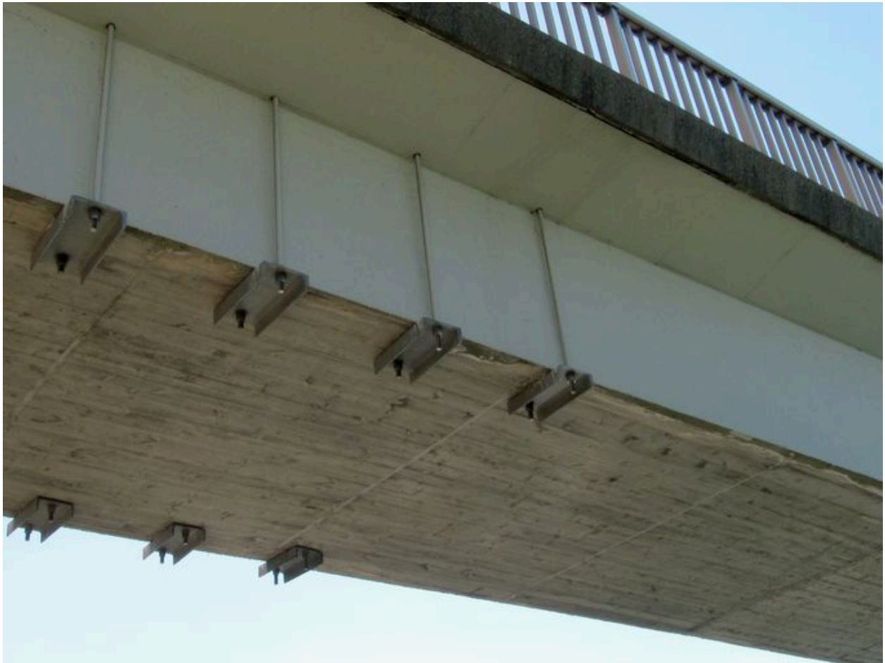
Tablier, vue partielle de dessous (depuis la rive gauche)
