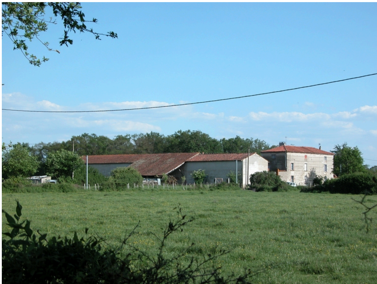
Vue générale depuis le nord-ouest.
