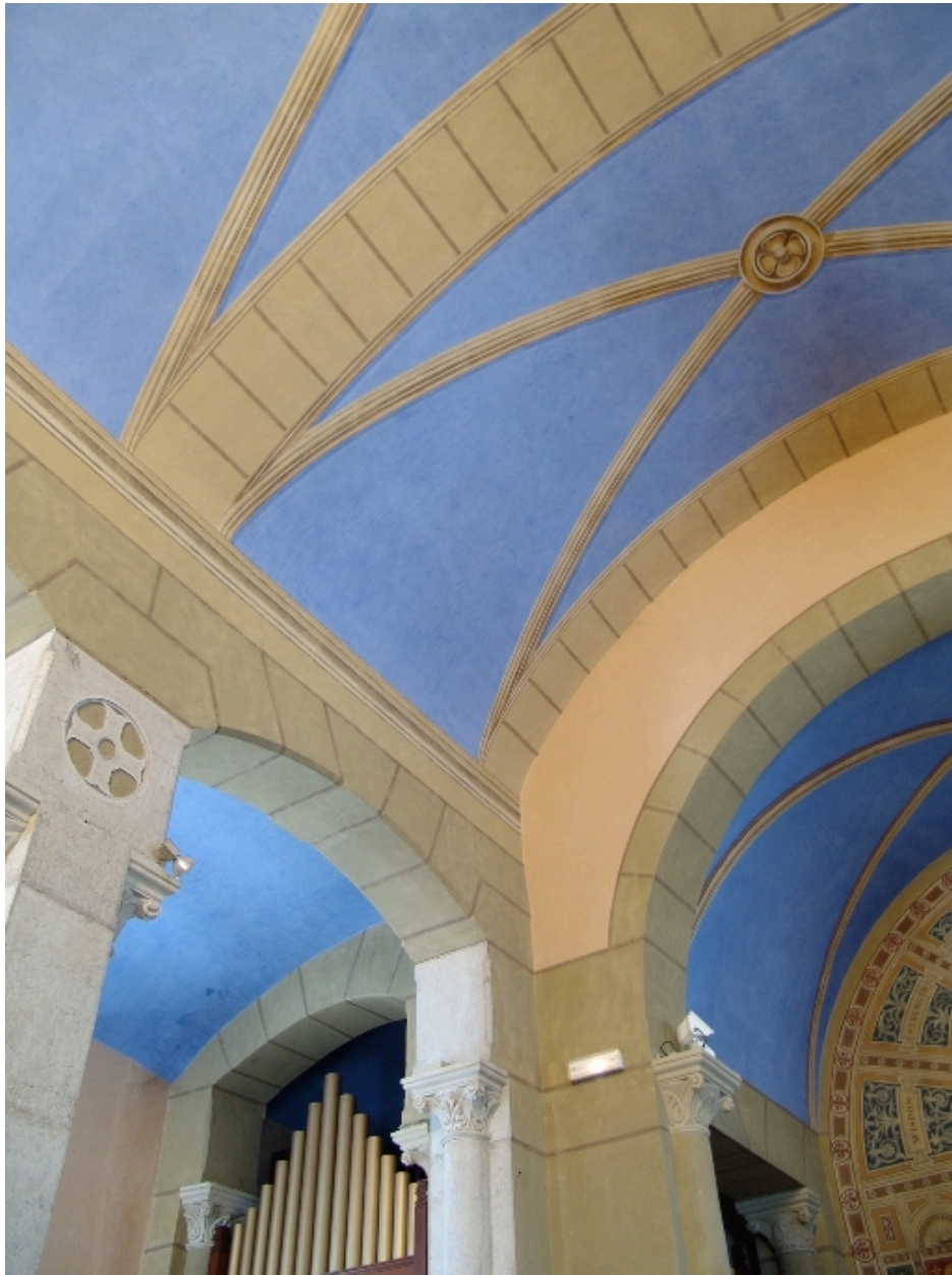
Détail de la voûte
