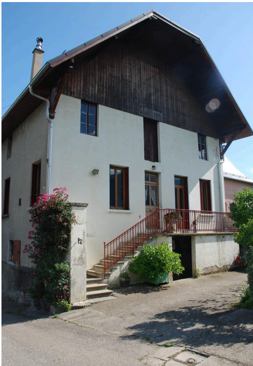
Maison de vigneron (2018 D3 737). Vue est.
