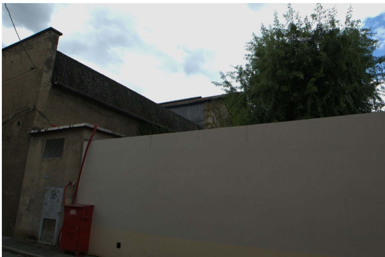
Détail toiture et halle centrale
