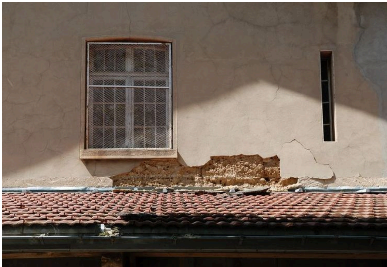
Bâtiment 456-457, façade postérieure (est) : mur en pisé
