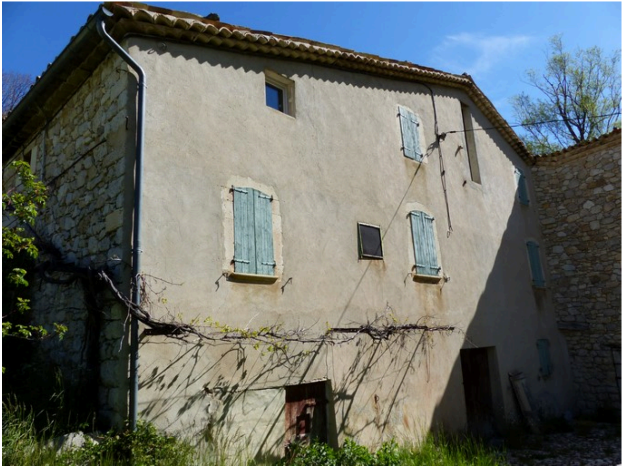
Bâtiment principal. Pignon sud.
