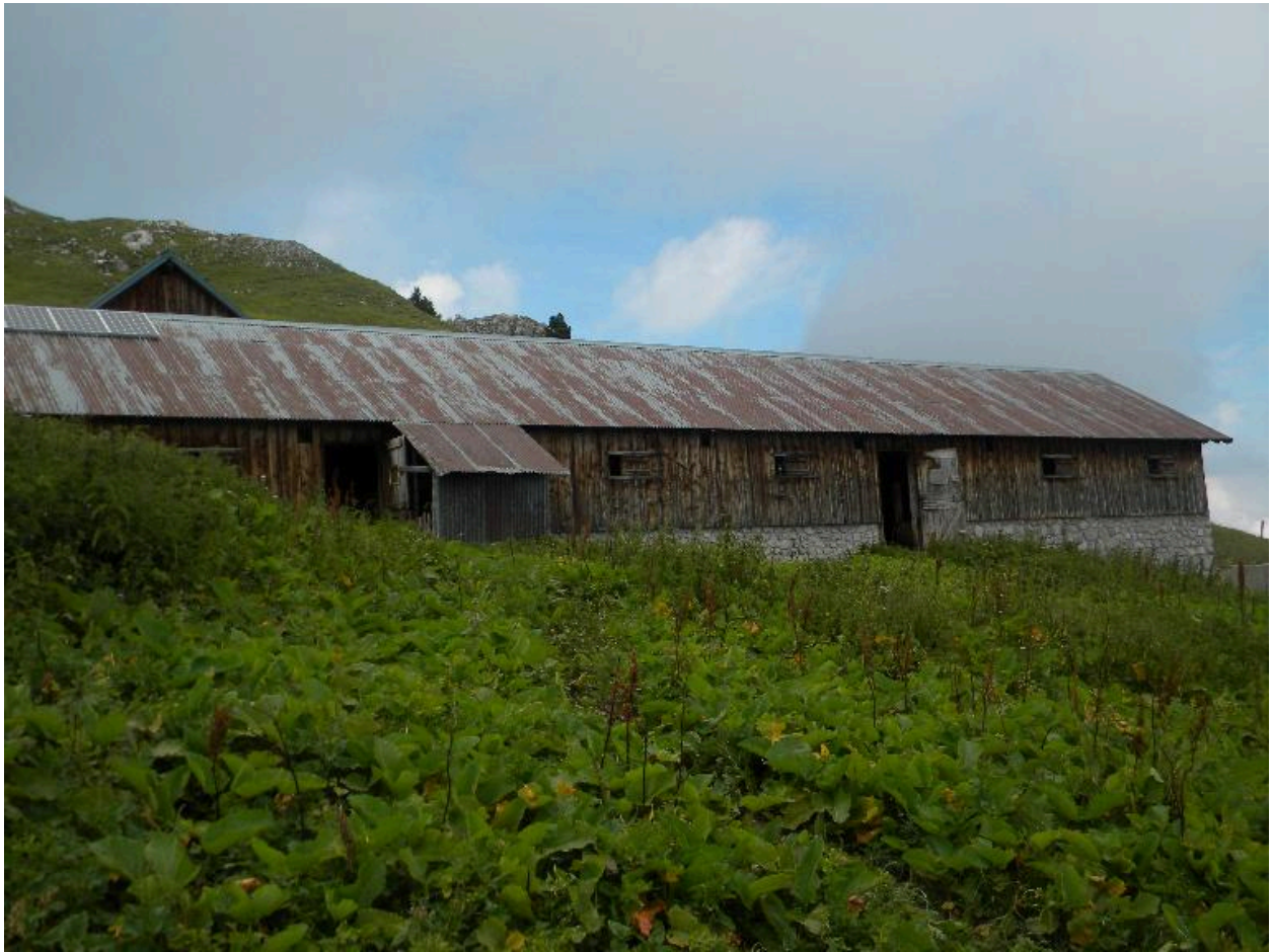
Vue d'ensemble de l'étable.
