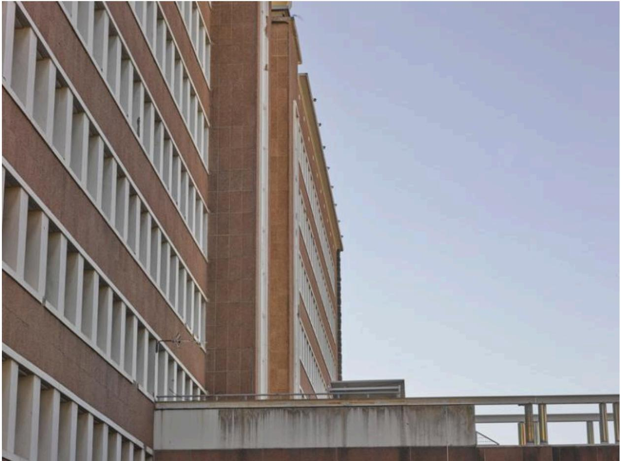
Vue depuis l'avenue Carnot sur l'élévation arrière du grand corps de bâtiment donnant sur le boulevard Fleury. Un jeu de lignes avec mise en évidence indirecte de la fameuse trame de 1,75 m (imposée par une circulaire datant de 1952).
