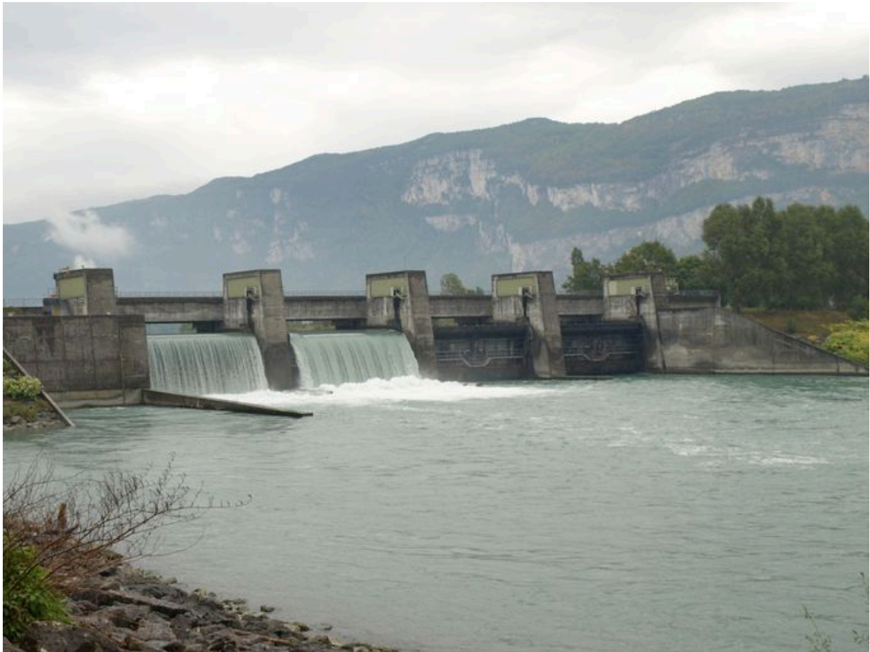
Barrage, face aval (depuis la rive droite)
