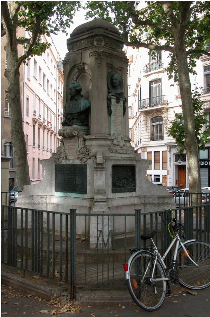
Vue d'ensemble. Faces Nord et Est.
