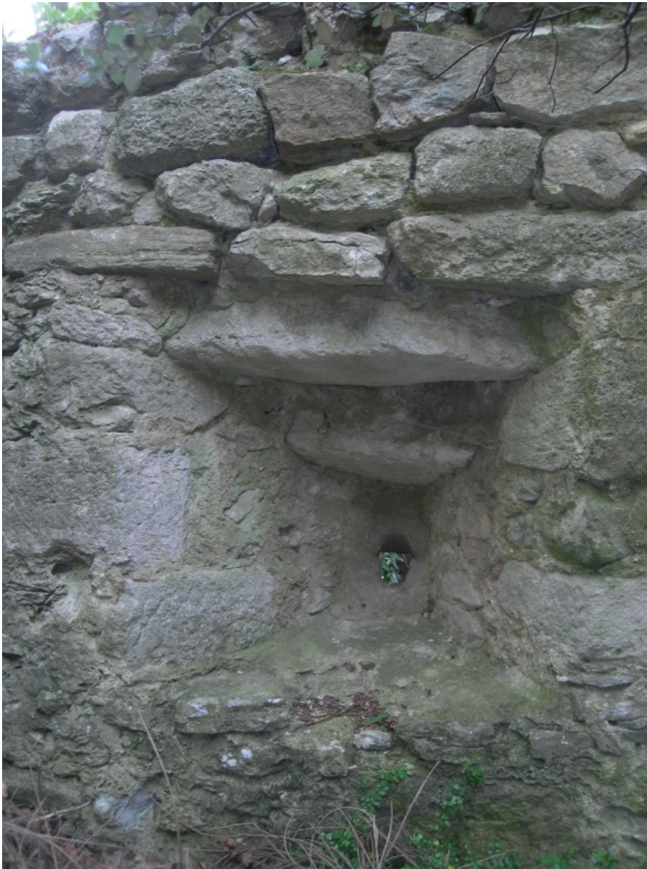
La Viale, ancien castrum : cannonière percée dans le mur sud vue depuis l'intérieur.
