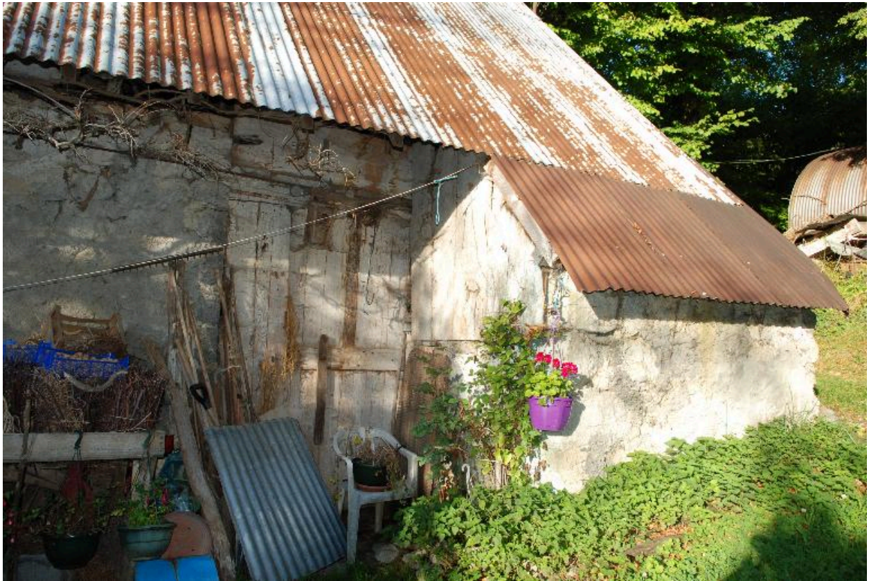
Détail de la porcherie en retrait de la façade principale orientée à l'est, côté droit.
