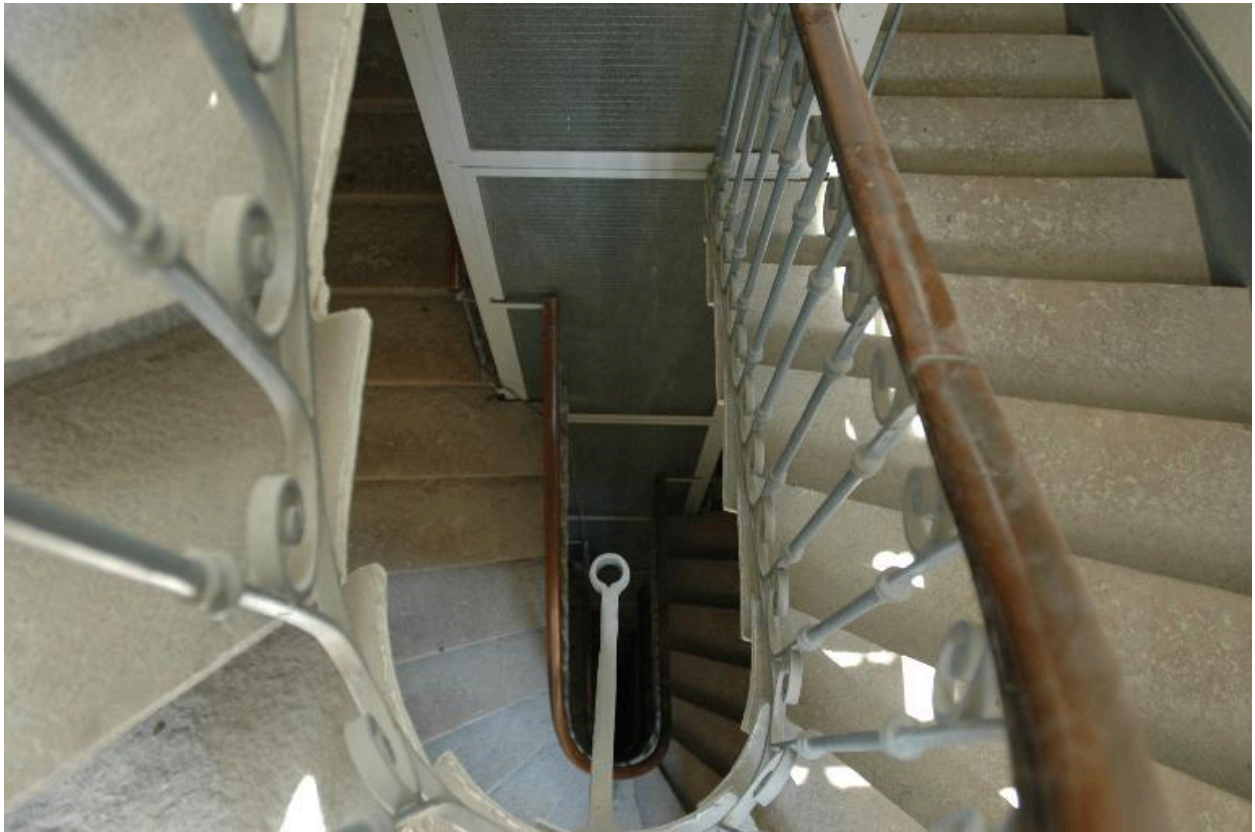
Vue intérieure : escalier
