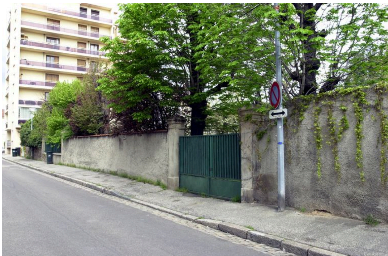
Clôture de la parcelle sur la rue Elie-Paris
