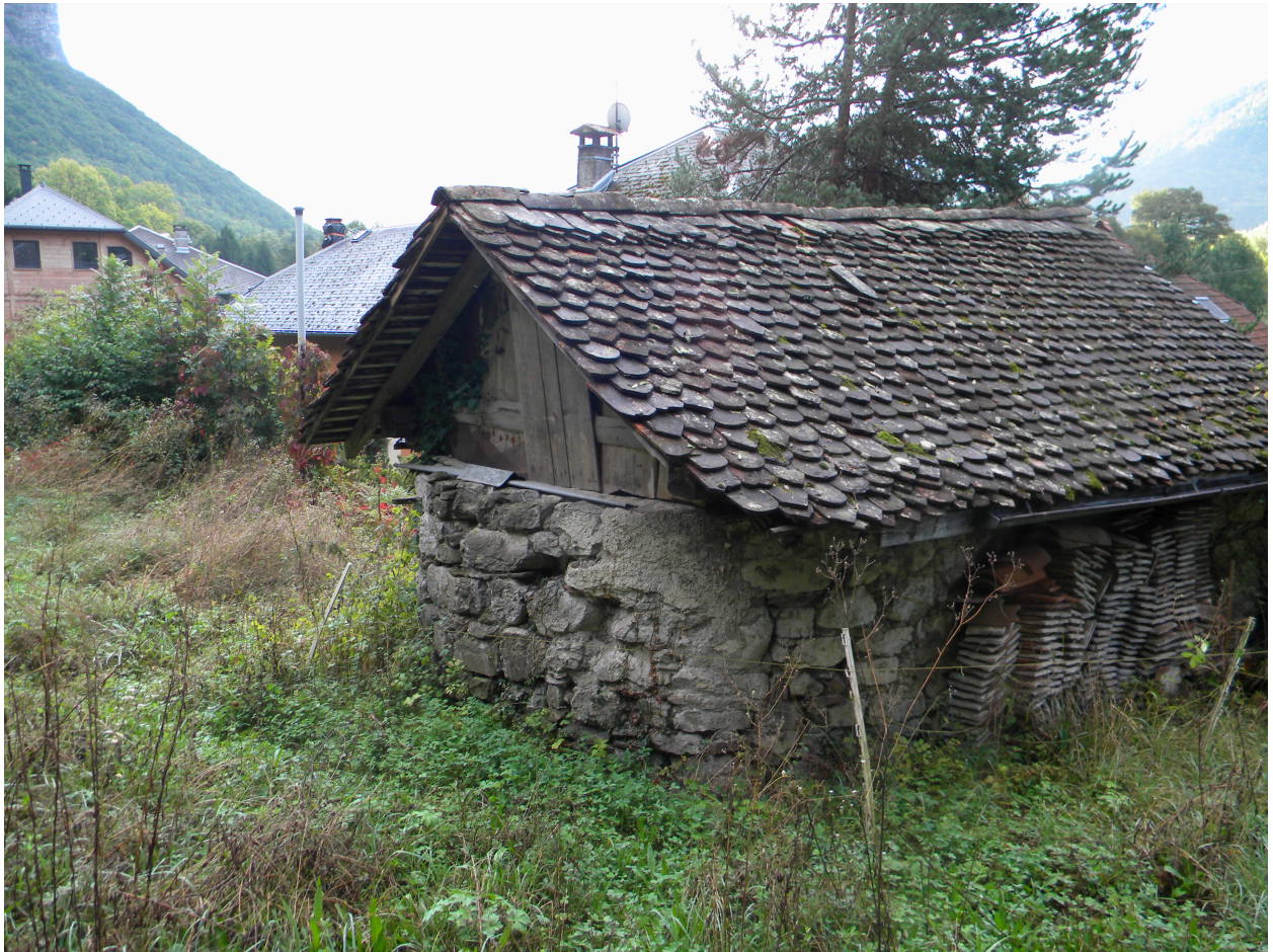
Vue de l'arrière du bâtiment en cul de four.
