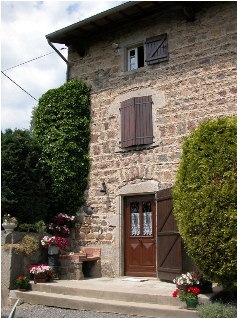
Détail de la travée de gauche de la façade sur cour du logis.
