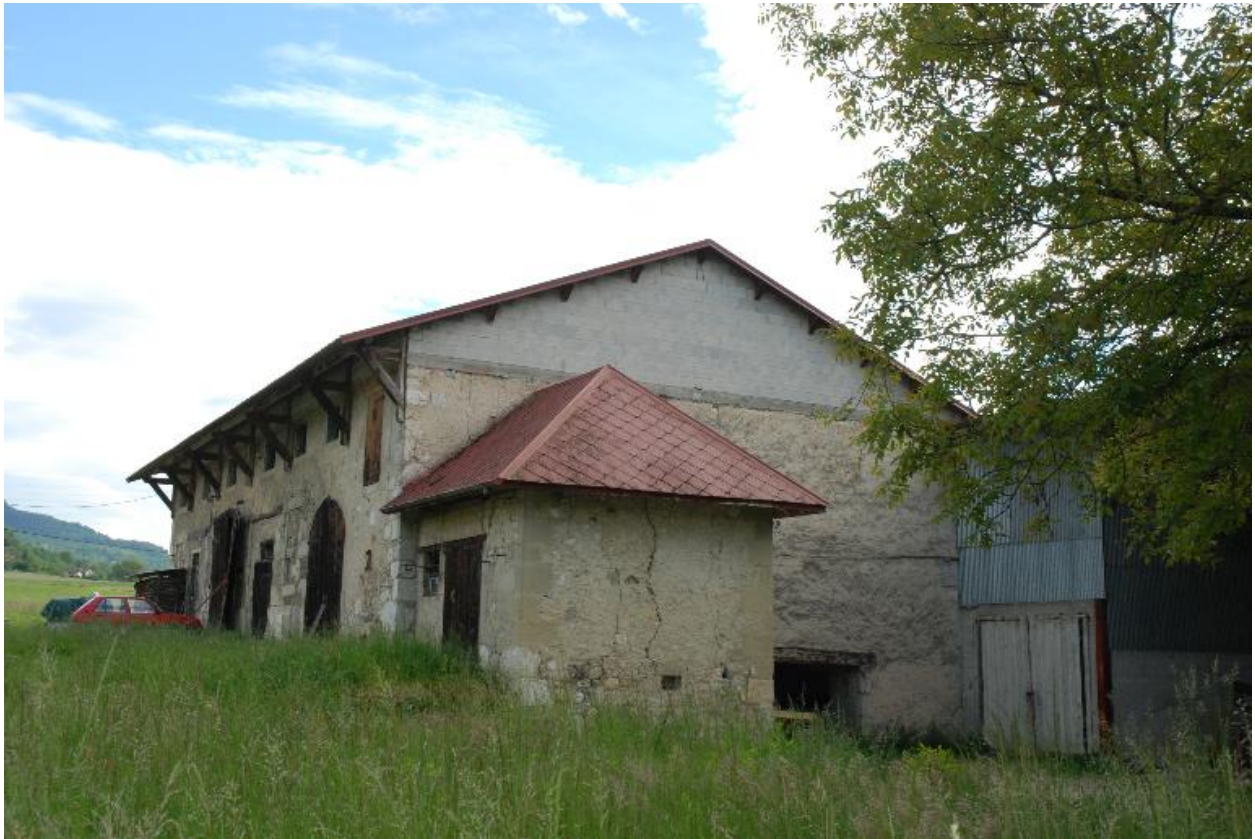
Bâtiment est, vue d'ensemble depuis le nord-est.
