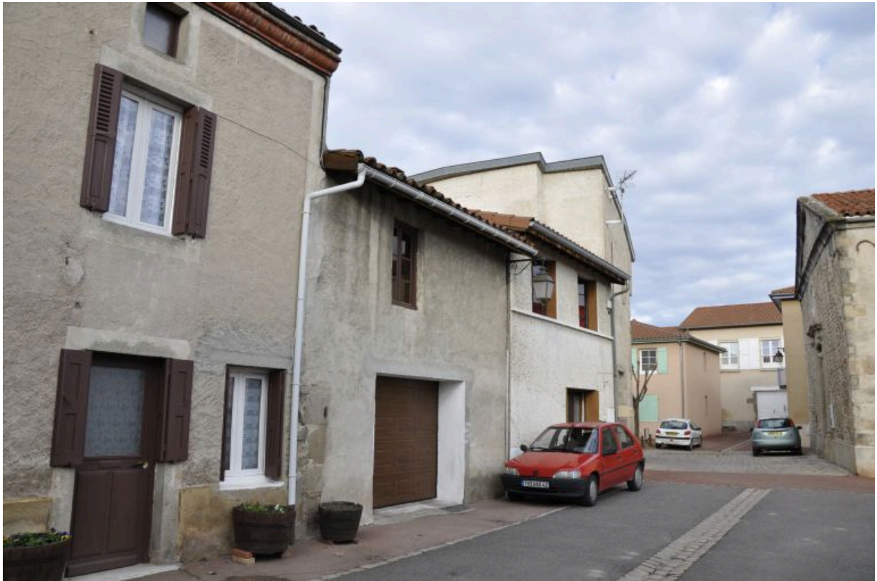
1986 AE 155, 156, 157, 2bis rue des Vignerons. Anciens cuvages, vue d'ensemble.
