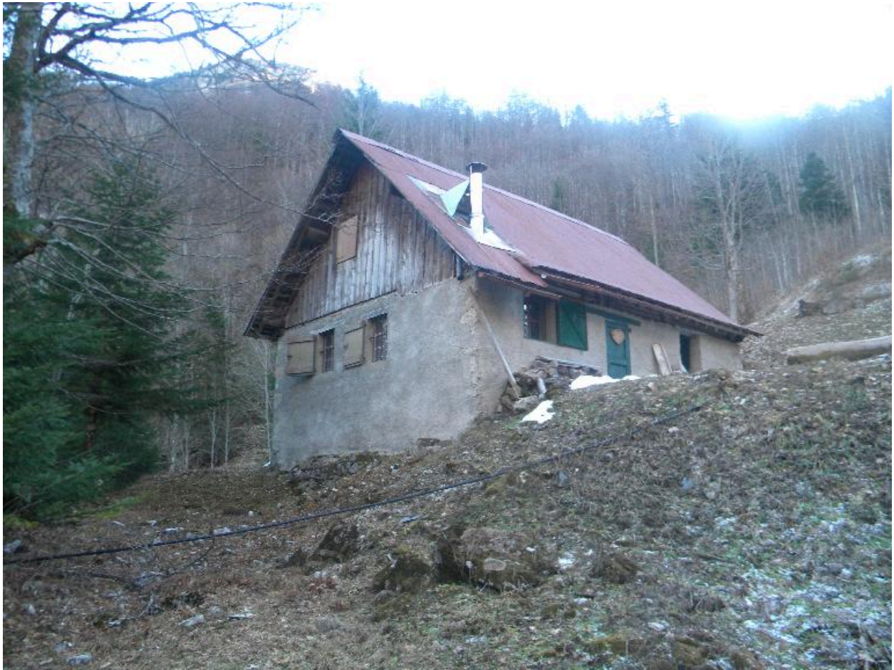
Vue de trois-quarts sud-ouest.
