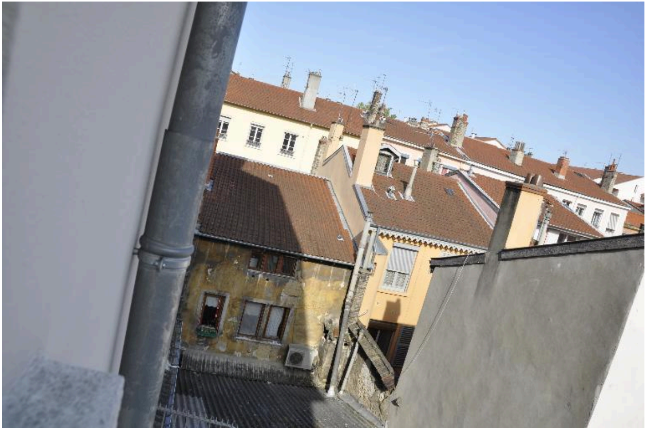
Vue d'ensemble sud est de la façade sur cour
