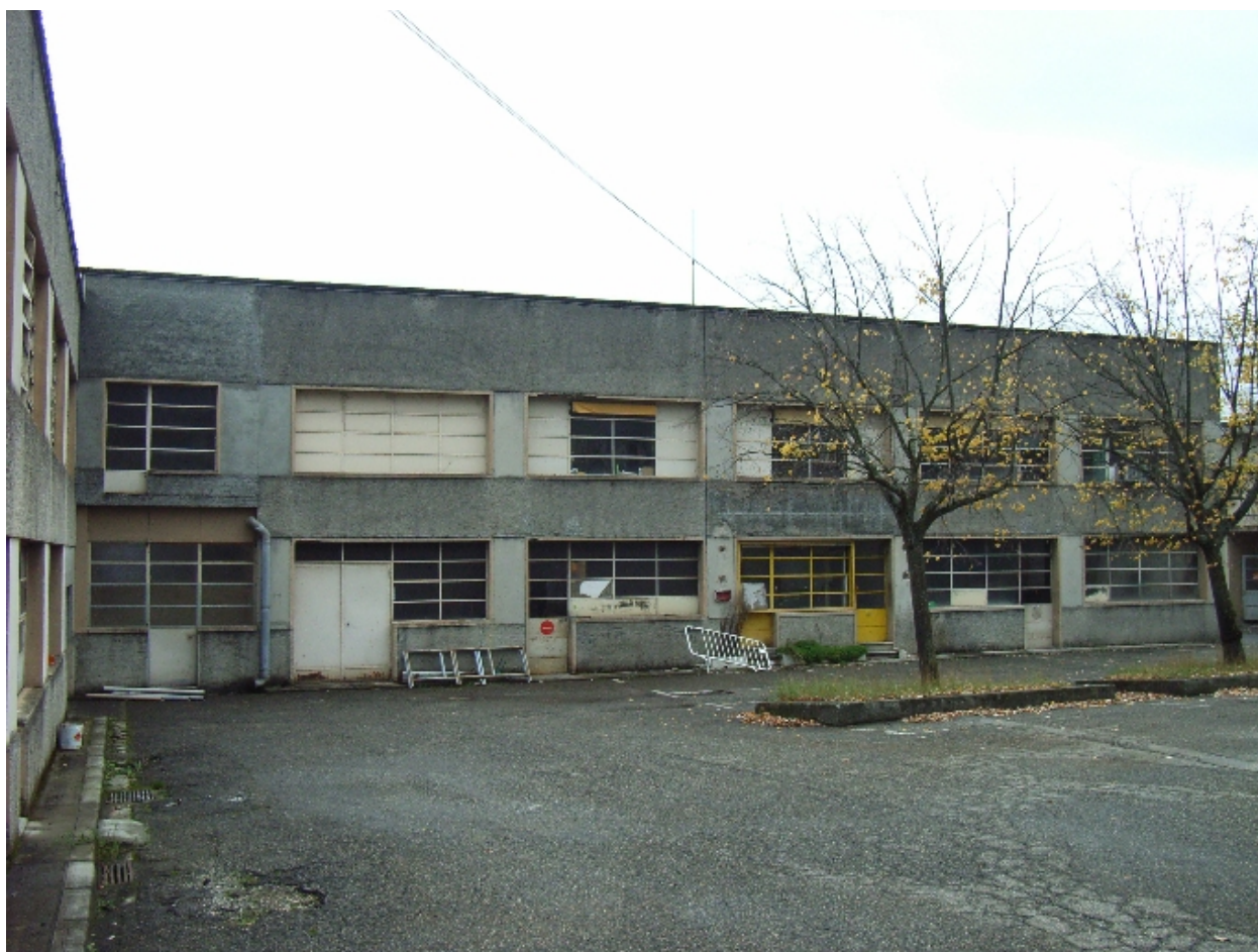
Bâtiment au fond de la première cour
