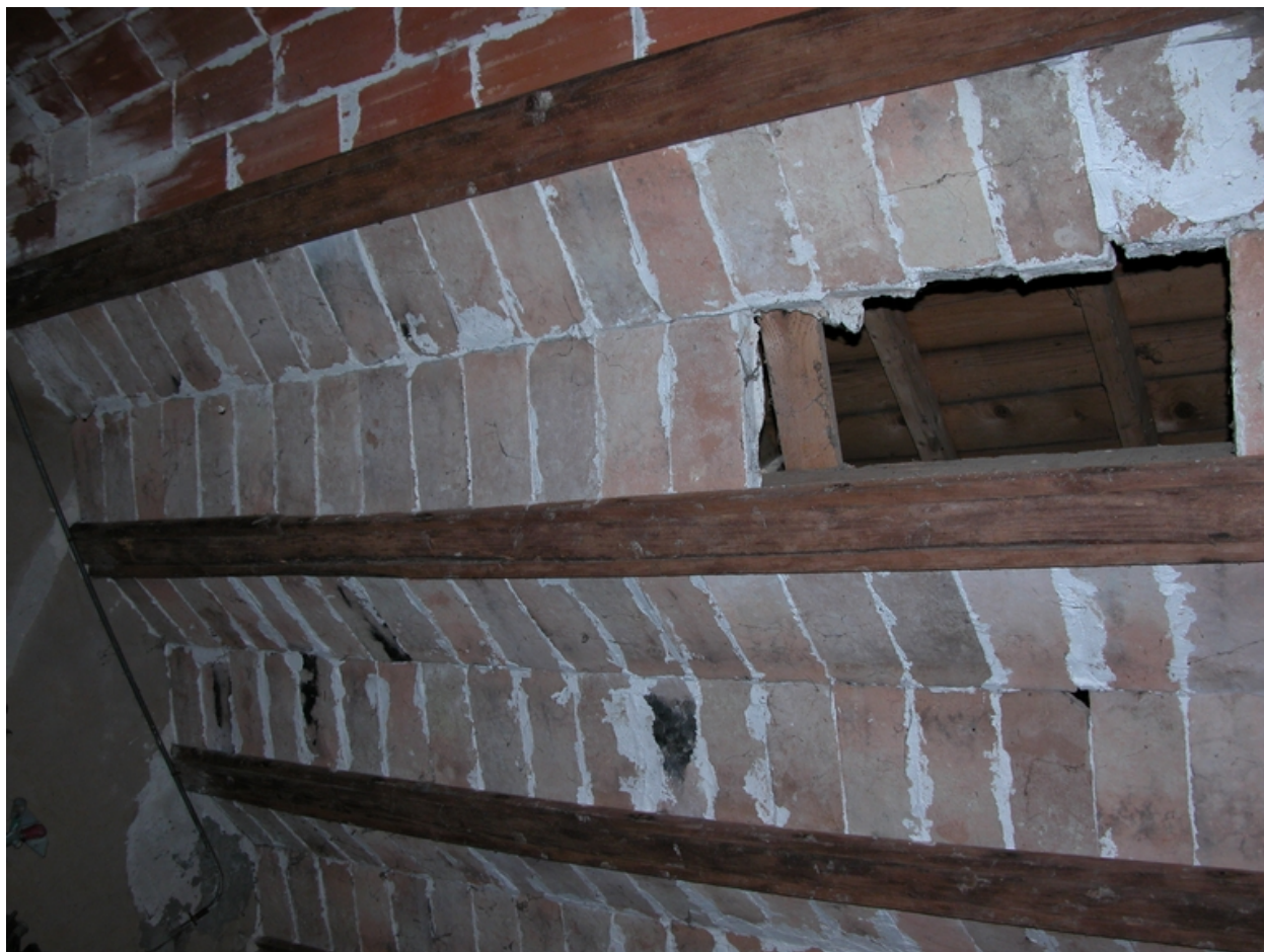
Plafond de la remise à betteraves.
