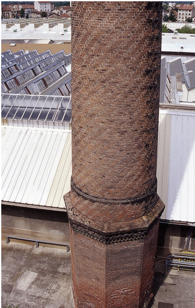
Embase cheminée, vue est
