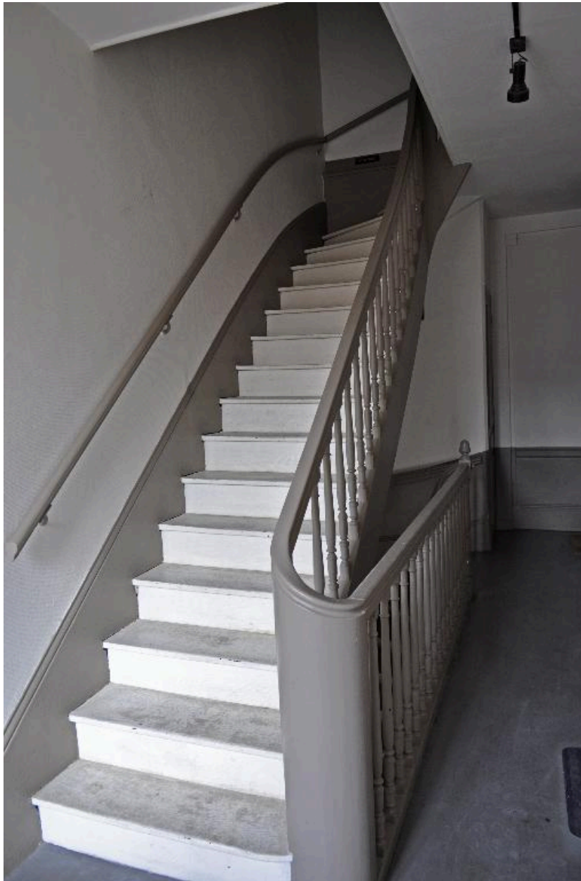
Vue intérieure : escalier en bois au dernier étage
