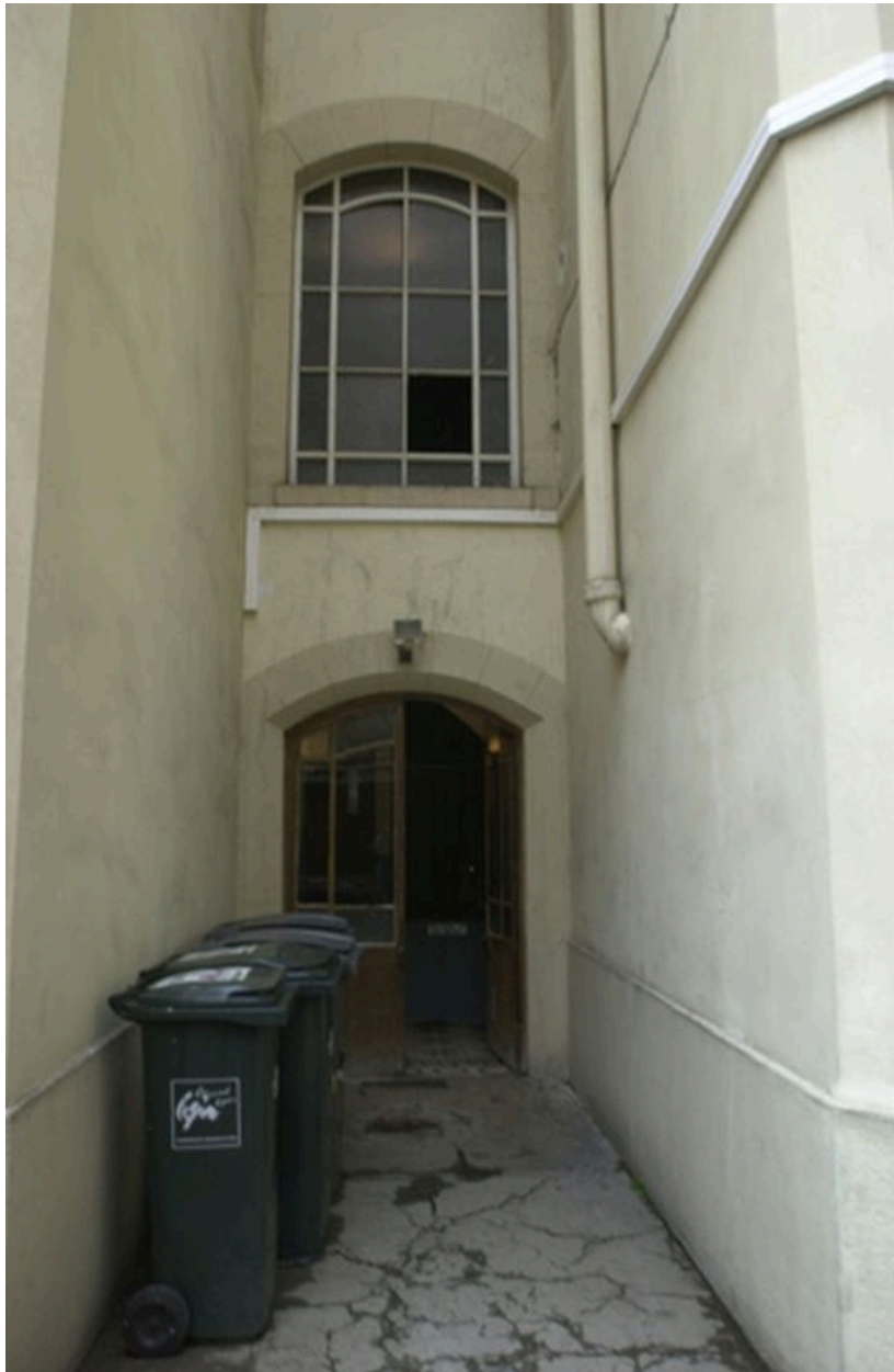
Elévation postérieure, rez-de-chaussée de la cage d'escalier
