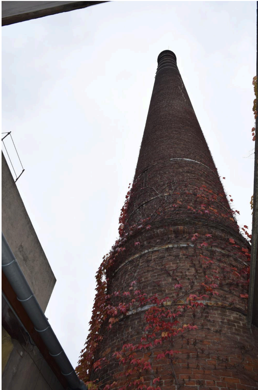
Détail cheminée en brique
