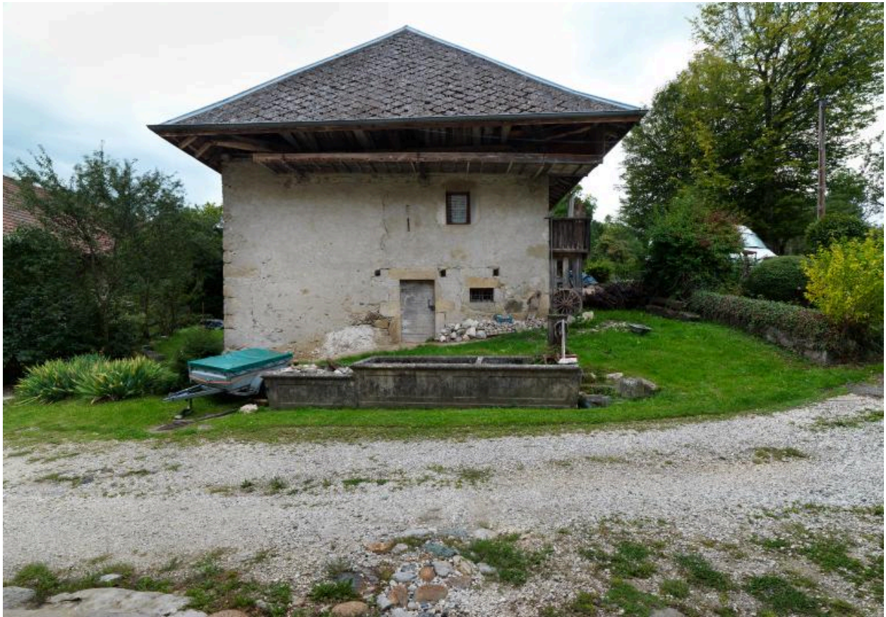
Vue d'ensemble du pignon nord.
