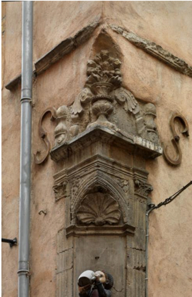
Niche d'angle : partie supérieure
