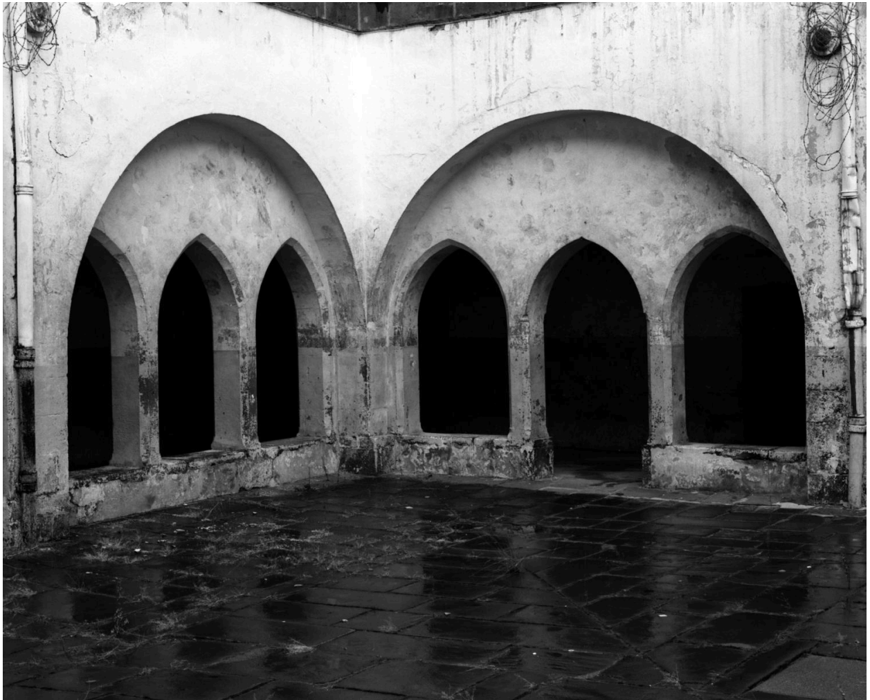
Cloître, à l'angle des galeries nord et est : groupement de trois baies jumelées (au nord) et triplet (à l'est).
