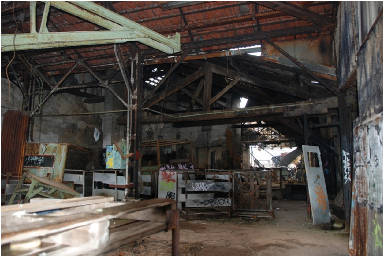
Vue intérieure : charpente en bois
