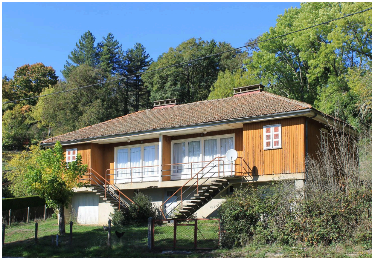
Neuvéglise-sur-Truyère - Fridefont, barrage de Grandval, maison à deux logements de l'ancienne cité, n° 2 rue des Frères Lumière.
