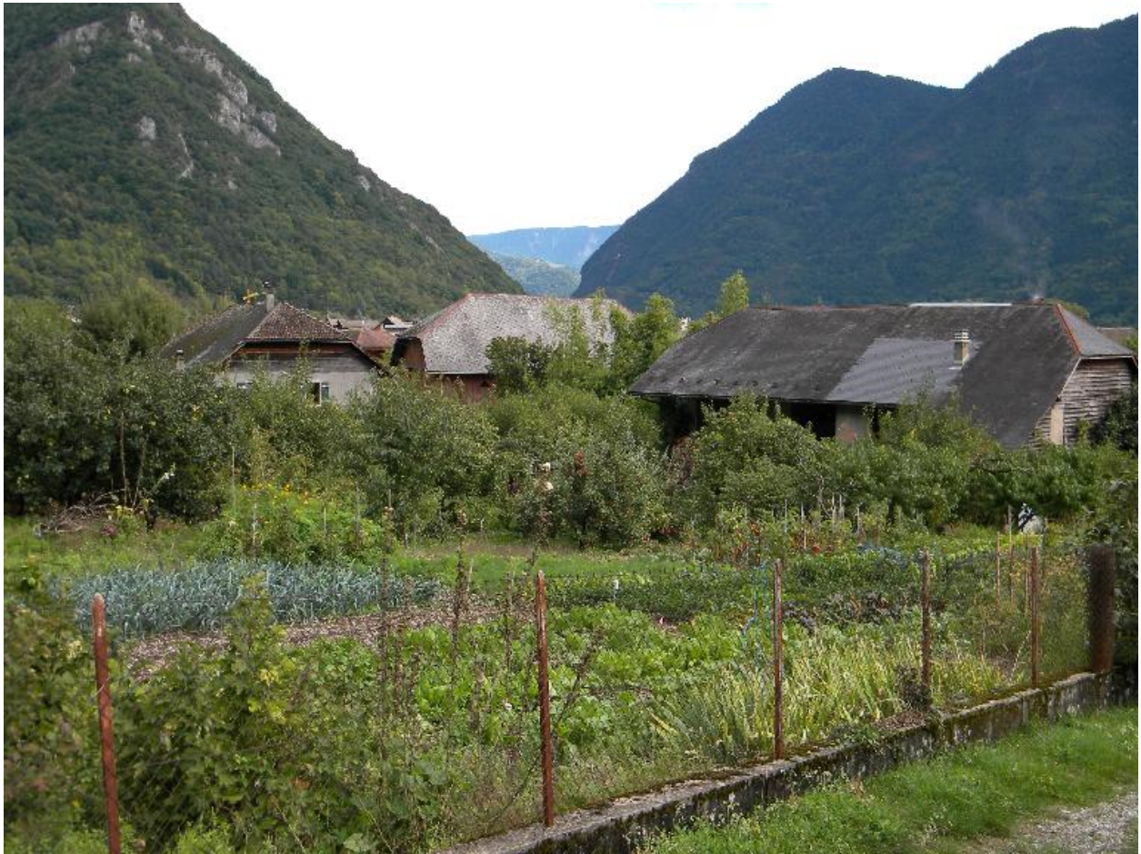
Vue d'ensemble des bâtiments des moulins et fruitières.
