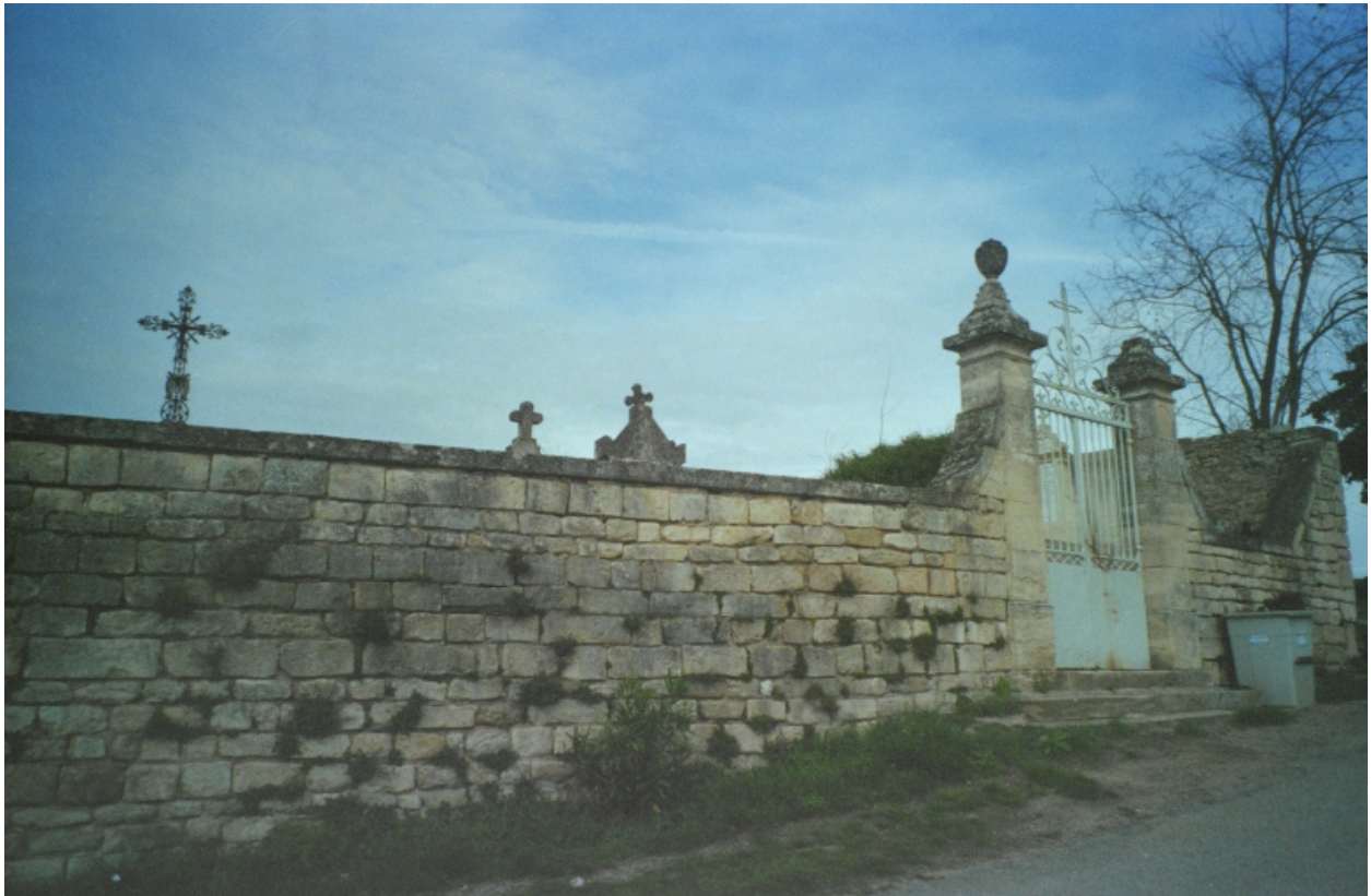
Le portail du cimetière et le mur de clôture, construit avec les pierres du prieuré.
