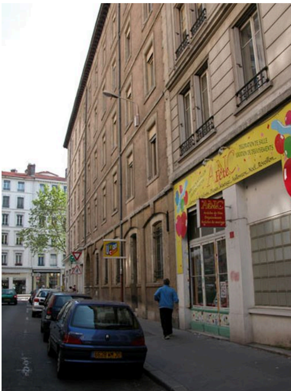
Elévation principale depuis le sud
