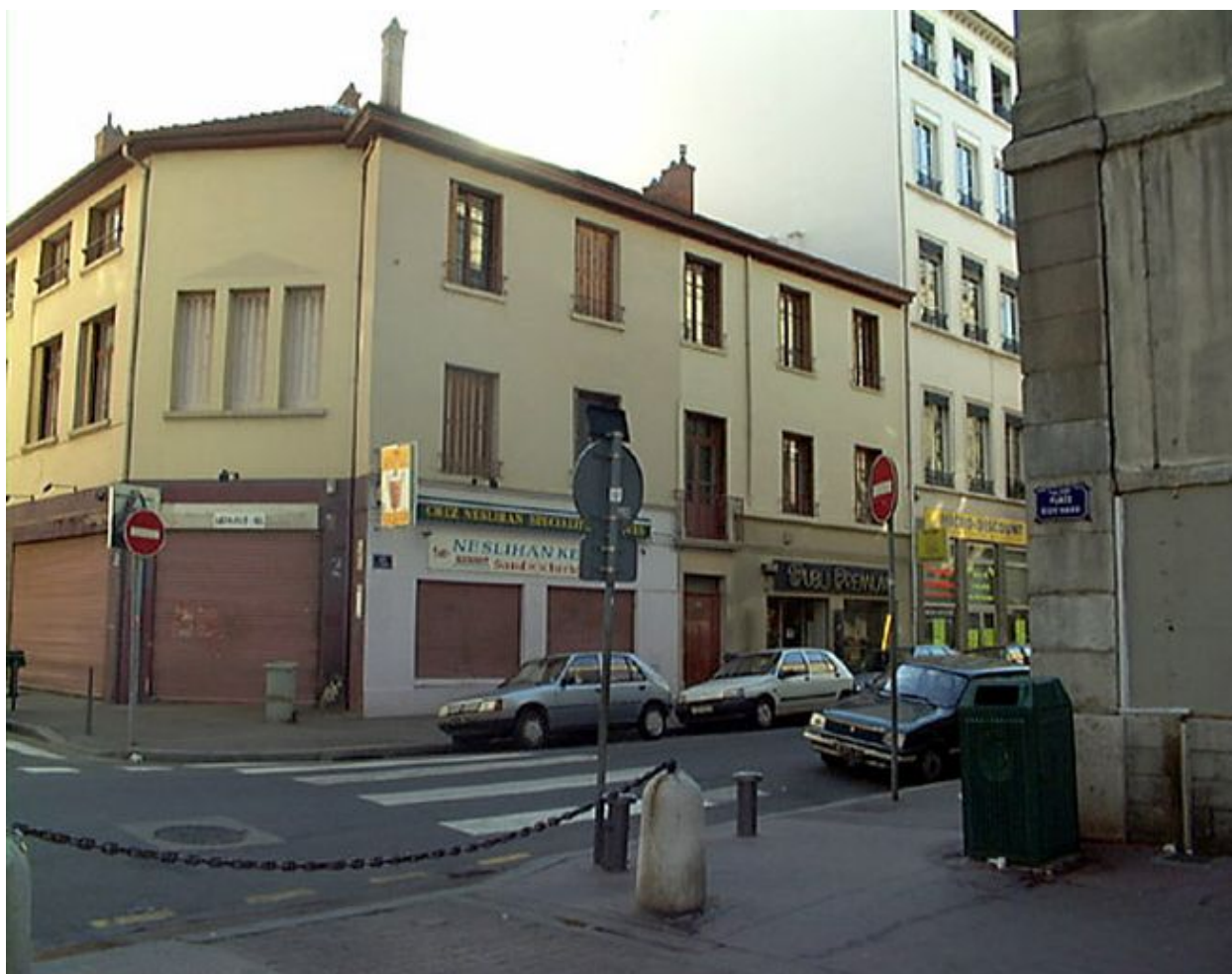
Façade sur rue, vue générale
