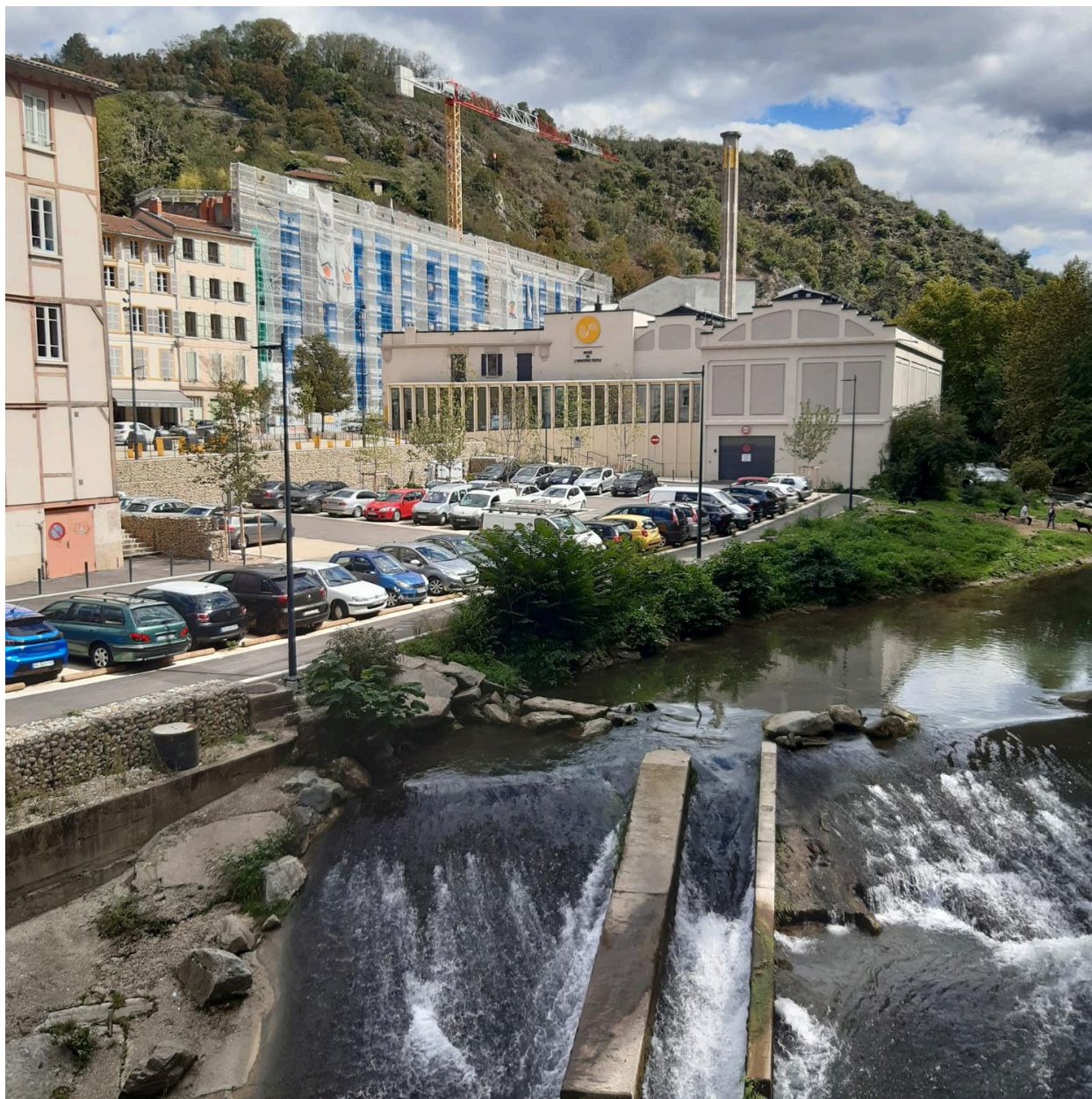
Vue d'ensemble extérieure après reconversion du site
