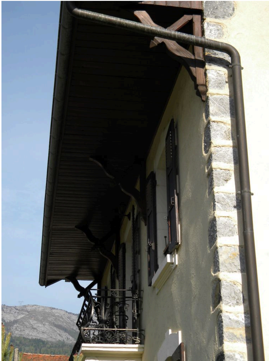
Détail du débord de toit avec ses jambes de force ouvragées.
