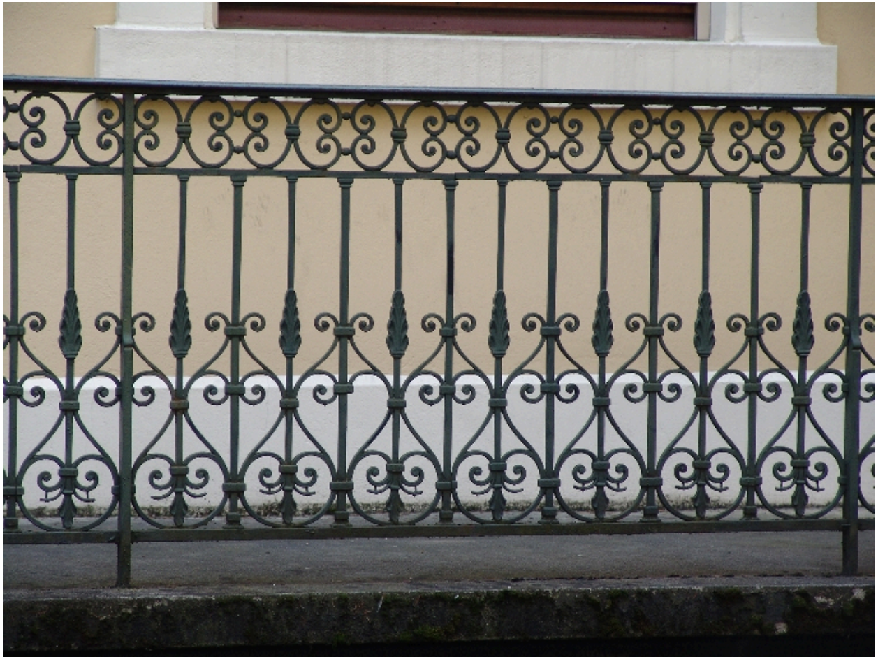
Garde-corps d'une passerelle
