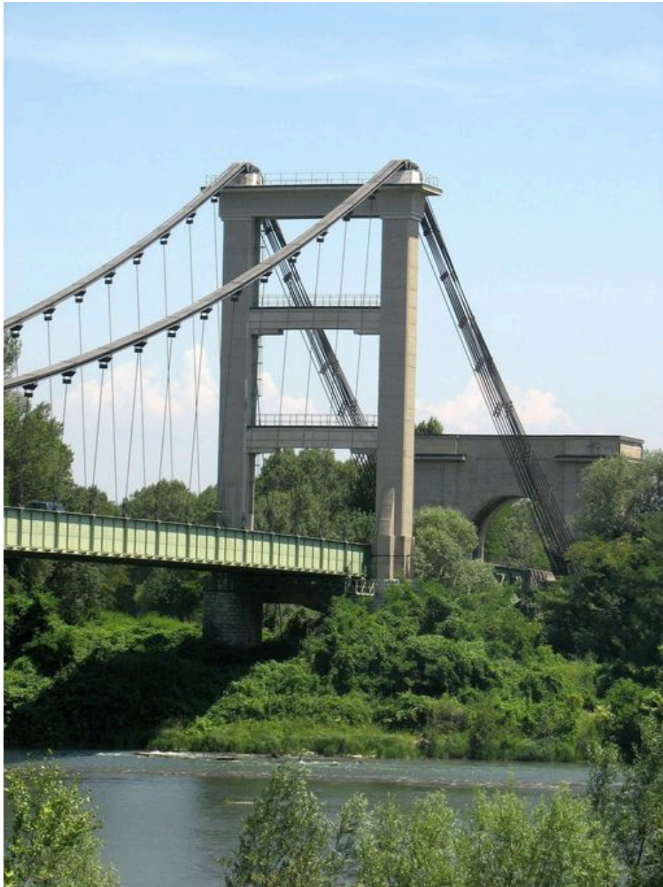
Vue partielle côté aval (rive gauche)
