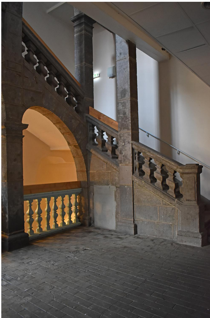
Escalier F : départ originel de l'escalier
